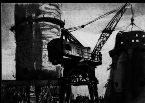
Монтаж доменной печи. 1953-1954.
